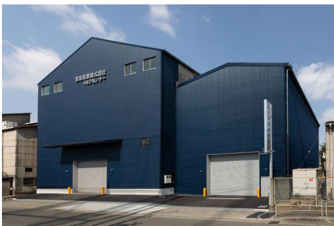
南東面外観（日中）
